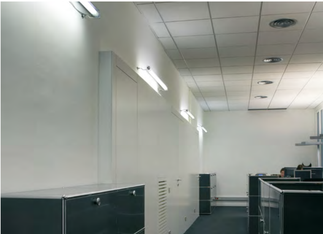
The ballast is located inside a white polycarbonate box. — El balastro queda alojado en una caja de policarbonato blanco.
